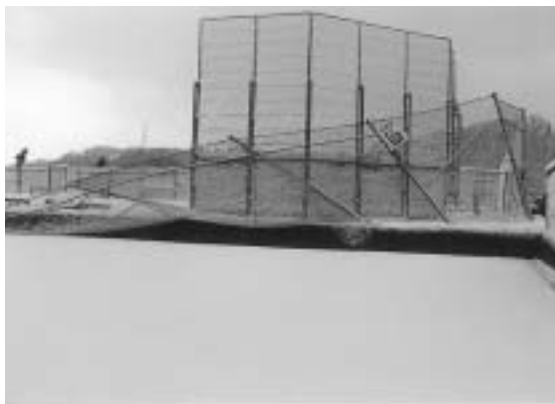
写真2 北陸大学薬学グラウンドを北西方向に観望したときの積雪の様子（1993.1.28）。ネットフェンスが着雪のため手前のテニスコート側に倒壊している。
