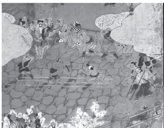
図2(2) 第2扇上部。石垣を積み上げる石工とその位置調整の補助する「手木之者」。
